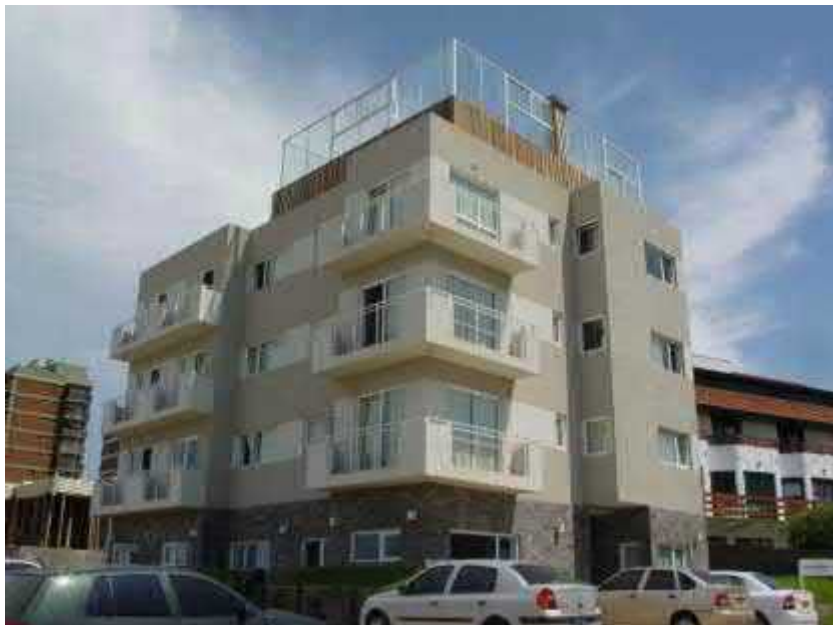
3-х этажный жилой дом с Бассейном на крыше
