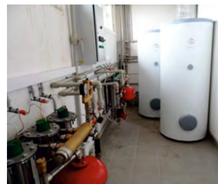
❖ Автоматизированный тепловой пункт модульного типа серии АТМ-Сочи
