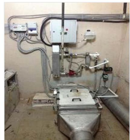
*Система воздушного отопления ATP-TermaRON/В*
